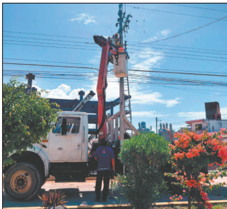
Comisión Federal de Electricidad repuso un transformador. (F. Baeza)
