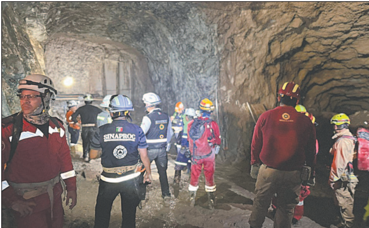
Las autoridades detallaron que persisten las tareas de limpieza de residuos y el sellado mecánico para reforzar la firmeza del terreno. (POR ESTO!)
