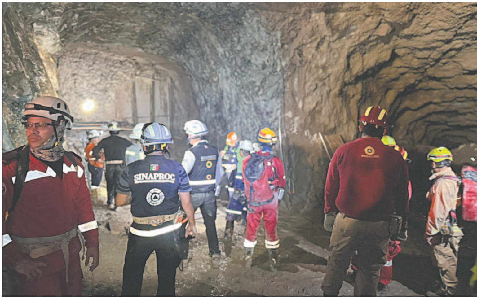
Las autoridades detallaron que persisten las tareas de limpieza de residuos y el sellado mecánico para reforzar la firmeza del terreno. (POR ESTO!)
