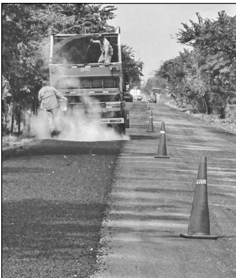
El proyecto contempla rehabilitación de 13 kilómetros de vía. (A. Pech)
