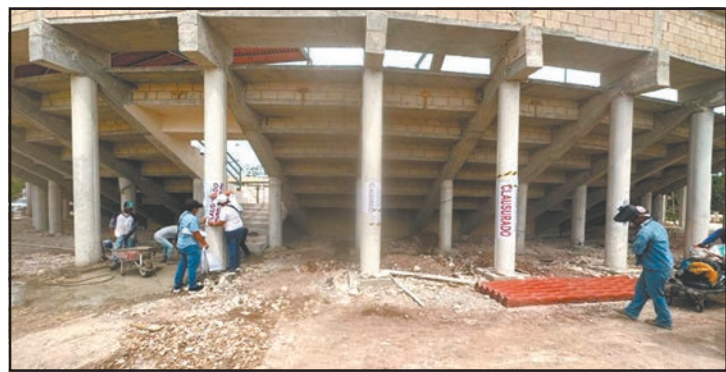
La obra no se concluirá por diversas irregularidades. (Ovidio López)
