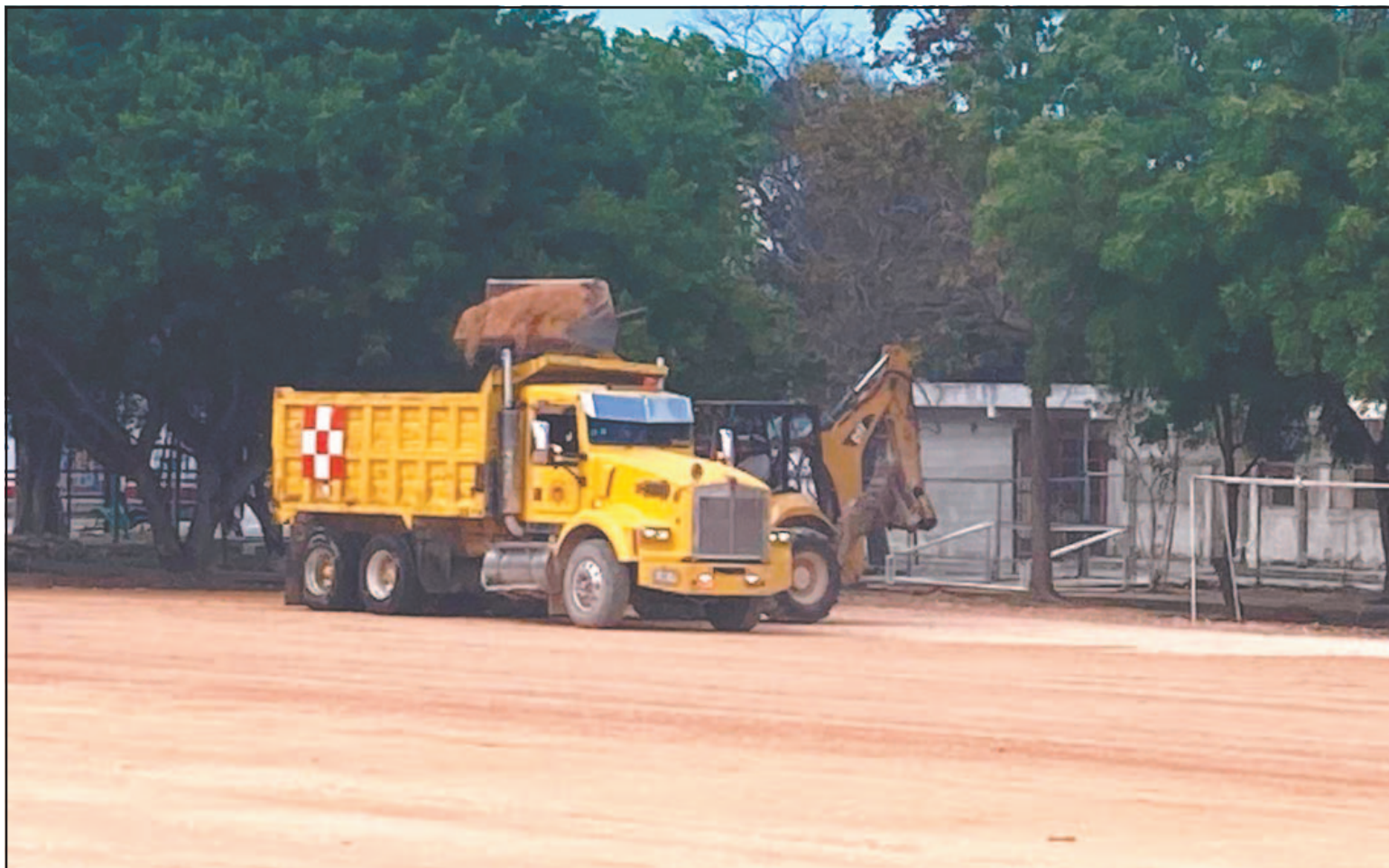
Mediante un recorrido, pudo constatar el trabajo de las máquinas, las cuales llevaban a cabo el aplanado del terreno. (Rafael García)
