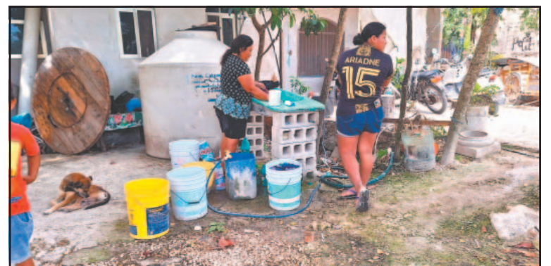
Paralizaron tres pozos el fin de semana por fallas eléctricas. (J. Xiu)
