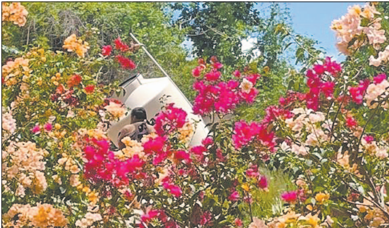
Al momento del hurto la casa se encontraba desocupada, lo que facilitó que el ladrón cortara los tubos de PVC y se llevara el depósito.
