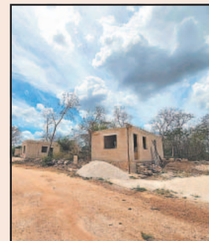
Pidieron la instalación de luz y agua potable. (E. C.)
