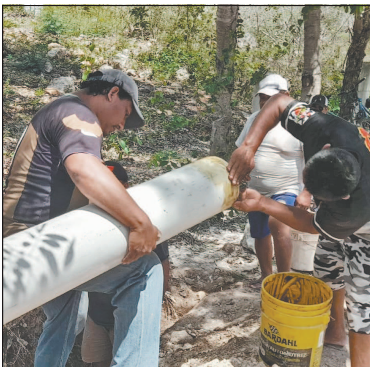
Se sustituyó parte de la añeja red de distribución. (Amado Caamal)
