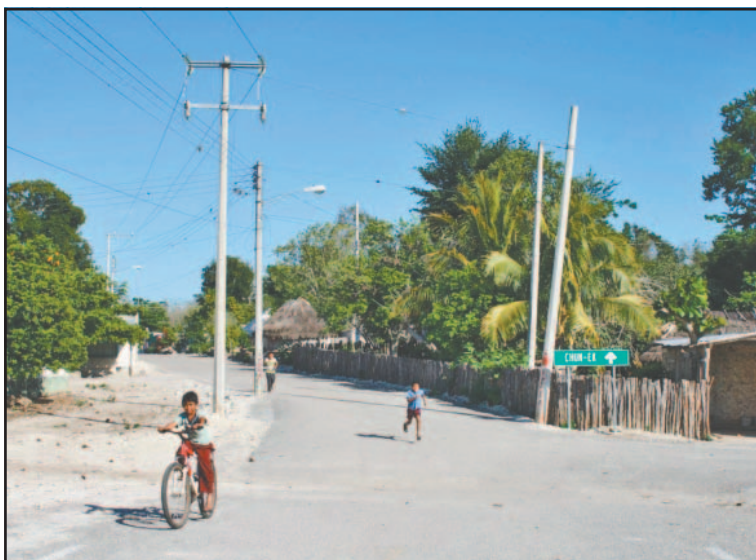
Más de 10 comunidades sufrieron su tercer corte prolongado de energía.
