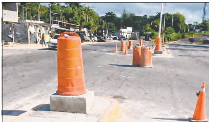
No hay fecha exacta para la conclusión de esta obra. (POR ESTO!)
