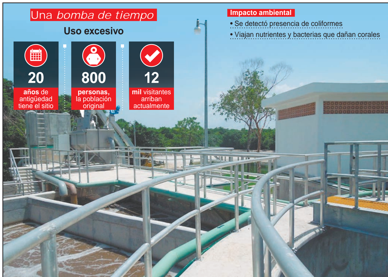
EL personal de la Conagua señaló que el sistema de saneamiento hídrico fue diseñado para atender a 5 mil habitantes; no obstante, el crecimiento inmobiliario y comercial ha elevado la demanda a más del triple de su capacidad.- (POR ESTO!)
