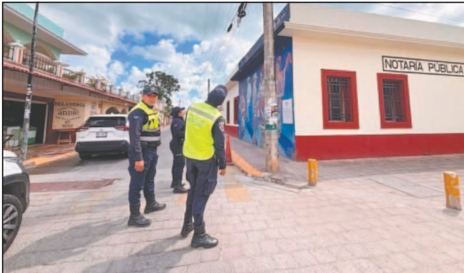
En la avenida 5 con calle 22 un ave se postró sobre los cables y generó una explosión.
