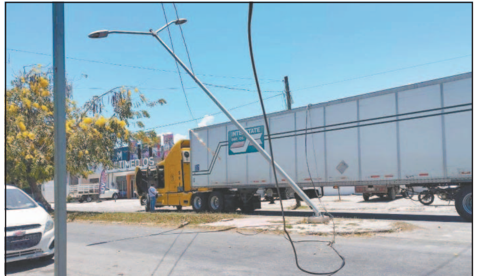
Un tráiler que iba rumbo a Chetumal dañó un cordón de corriente. (Fotos Efrén Martín)
