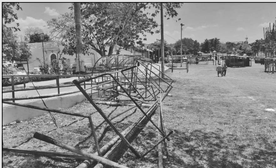
Las estructuras son vistas como un obstáculo y como un riesgo para las familias. (Erik Caamal)
