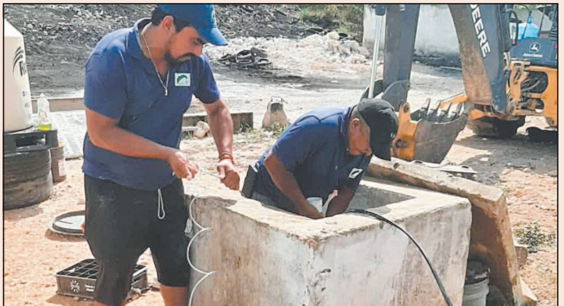
Trabajadores revisan la situación de las intermitencias en las redes de abastecimiento. (POR ESTO!)
