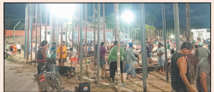
Los palqueros empezaron con la construcción. (POR ESTO!)
