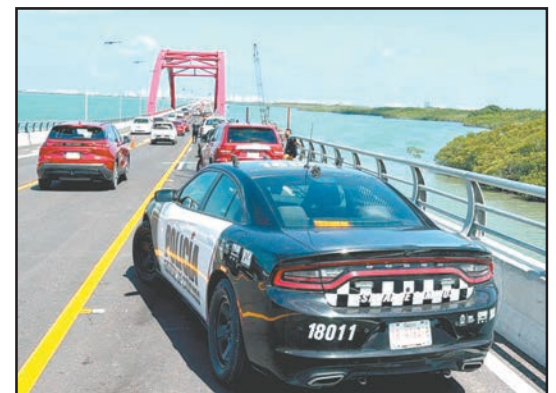
ACCIDENTES, invasión de carriles y embotellamientos marcan los primeros días de operación del nuevo paso vial elevado.- (G. Alcocer)
