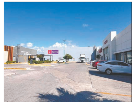
CABLEADO quemado e interrupciones eléctricas constantes mantienen incertidumbre entre negocios y locatarios afectados.- (G. Escalante)
