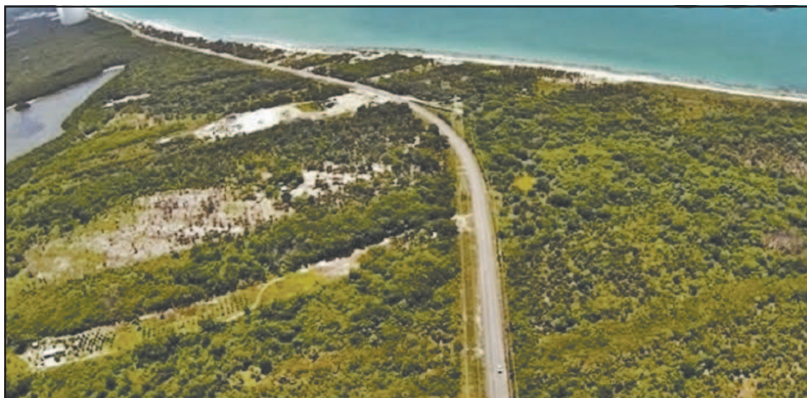
Uno de los reclamos persistentes es mayor infraestructura carretera, para evitar accidentes. (Especial)
