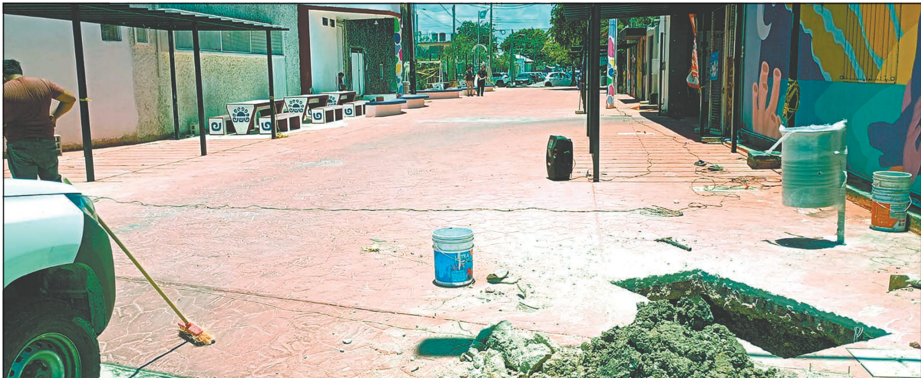
Habitantes señalan que desde hace meses permanece material de construcción en un predio contiguo; los trabajos siguen sin concluir, pese a que debían terminarse en octubre del 2025. (F. Olvera)
