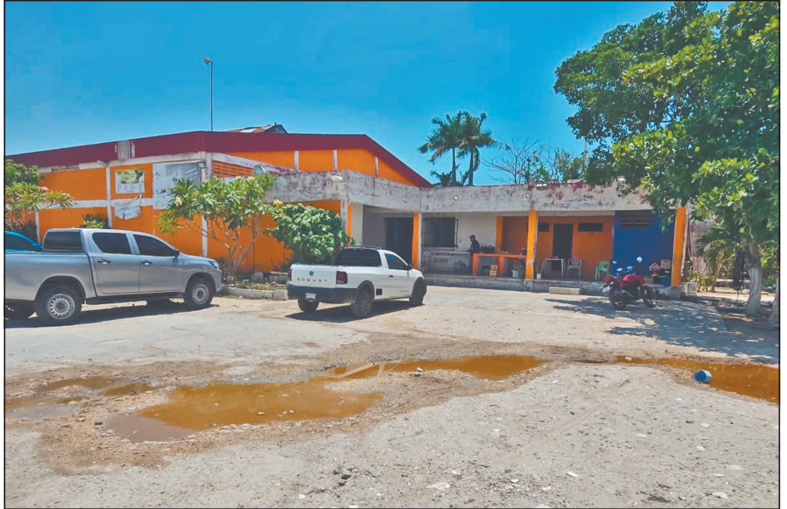
El edificio, que tiene más de 3 décadas de fundación, presenta desde goteras hasta el estacionamiento lleno de baches. (Alejandro Pech)
