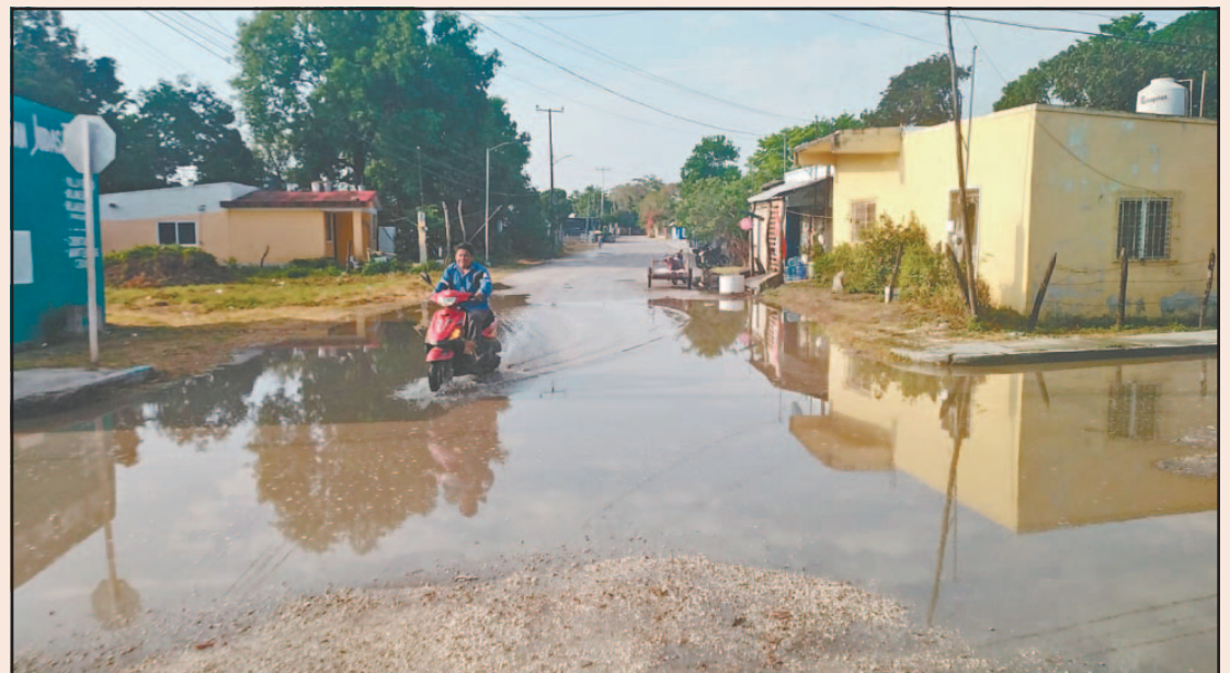
Pidieron la construcción de drenajes y un programa emergente de bacheo para tapan los hoyancos.
