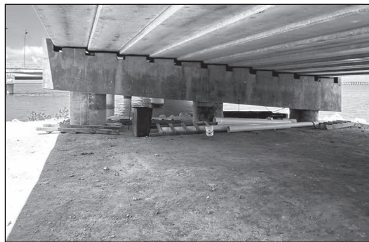
En los trabajos se invirtieron más de 10 mil 319 millones de pesos.
