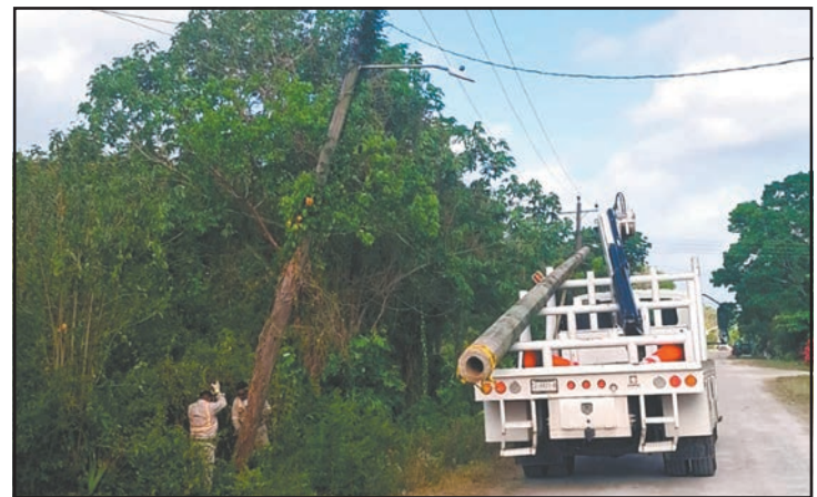
Desde temprana hora inició el reemplazo de postes dañados. (J. Xiu)
