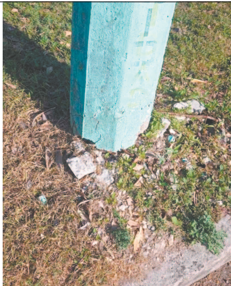
Los quejosos destacaron que el desperfecto resulta aún más preocupante debido a que el pilar sostiene cables de alta tensión. (Fotos F. Olvera)
