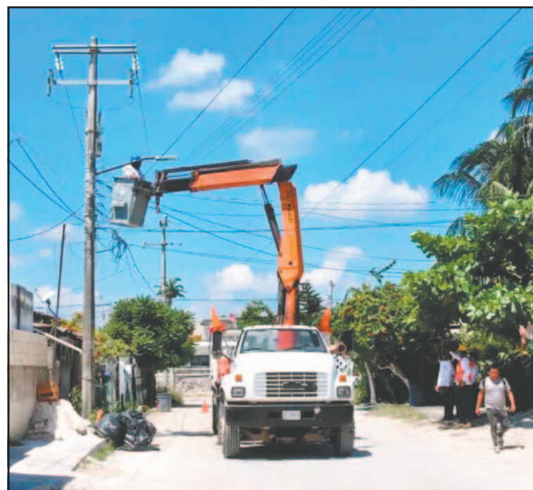
Alegaron daños en equipos eléctricos de las casas. (POR ESTO!)
