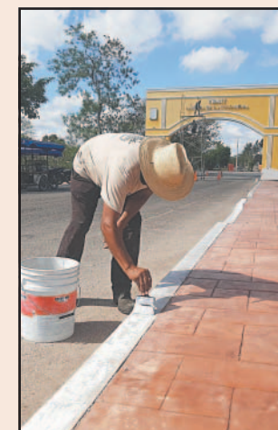
Efectúan labores de pintura y resanamiento. (J. Borges)
