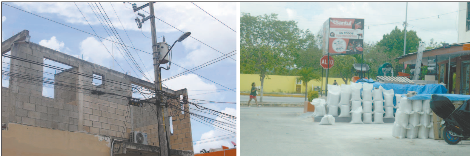
Ampliaciones de vivienda en Villas de Mar resultan peligrosas al estar cerca de cables eléctricos, mientras que en estacionamientos de la Sm. 251 almacenan bultos. (Fotos E. Romero)
