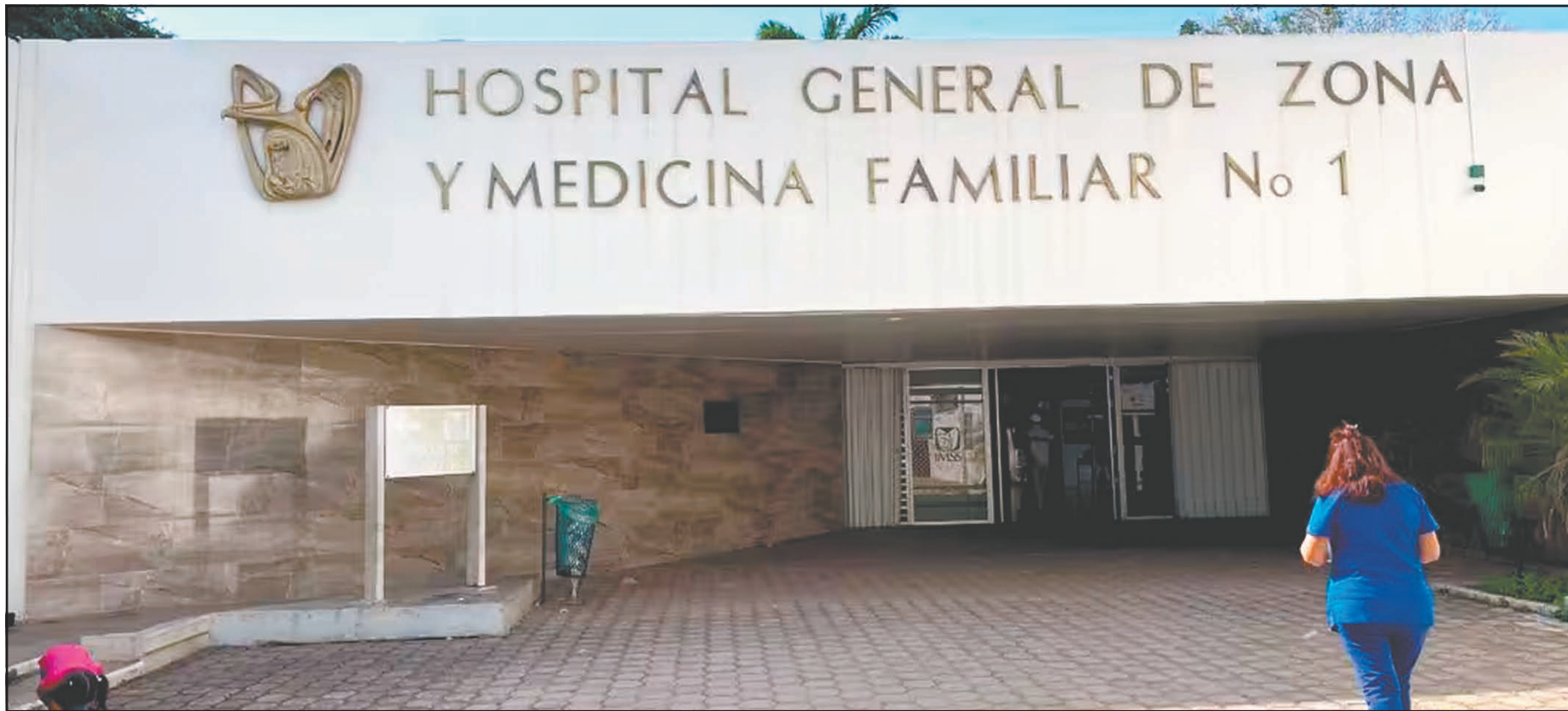
El nuevo nosocomio se ubicará atrás del Centro Oncológico, lo que permitirá aumentar la capacidad de atención a la derechohabencia en el sur de Q. Roo. (Fotos E. Martín)
