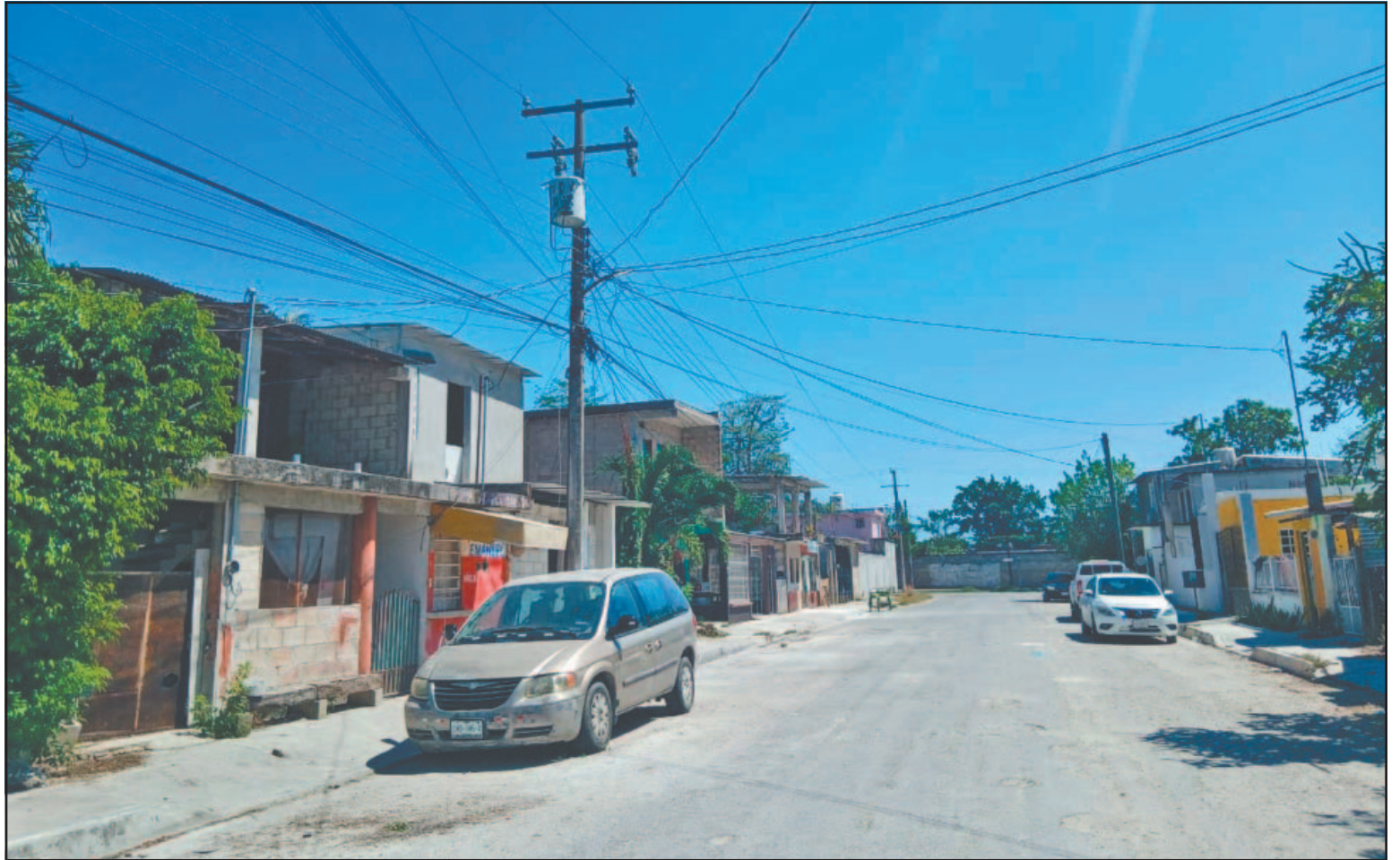
Hasta el cierre de la edición no contaban con el suministro de electricidad, y tampoco había llegado la cuadrilla de la CFE. (Joaquín G.)
