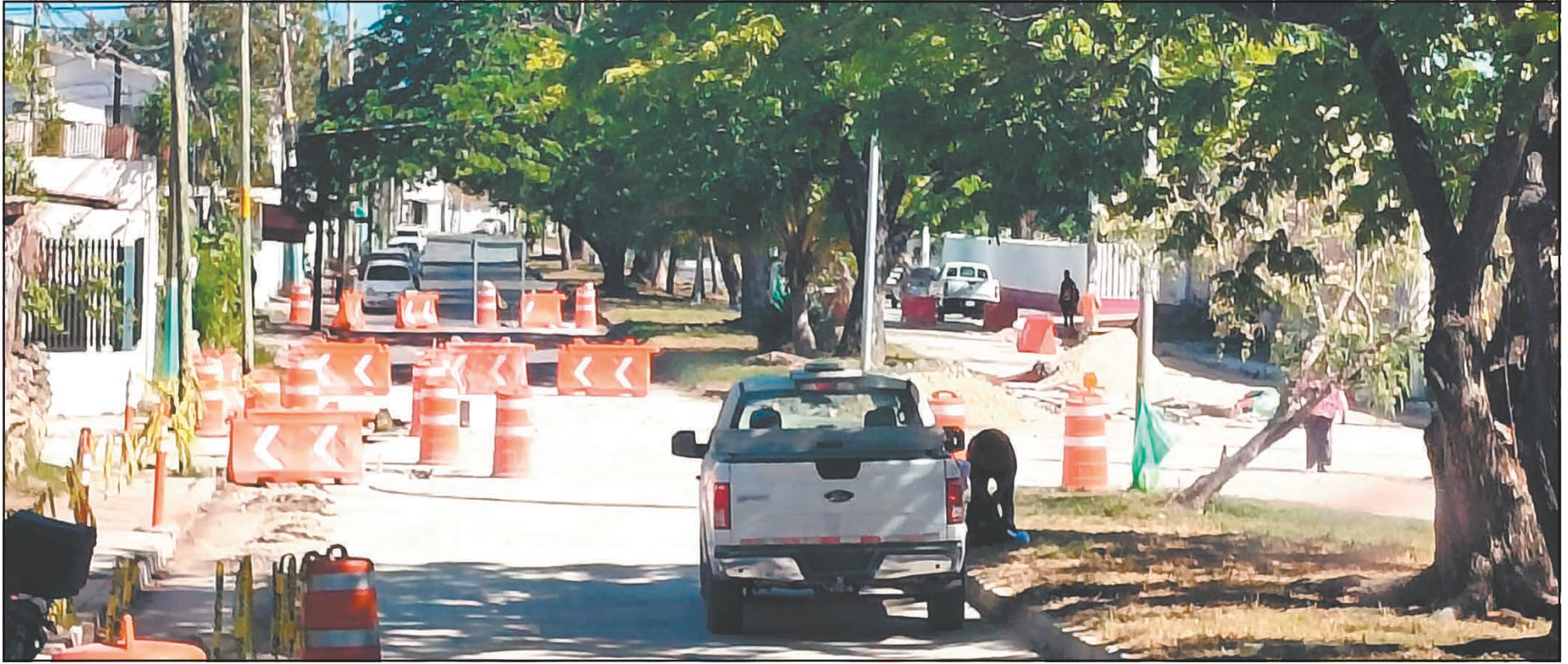
Cerca de 100 obreros provenientes de Querétaro y Veracruz trabajan en dos turnos diarios para acelerar el avance, lo que afecta el descanso de los vecinos. (F. Baeza)
