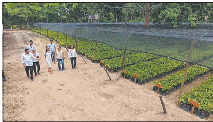
Se construirá una planta a donde se destinará el fruto. (POR ESTO!)
