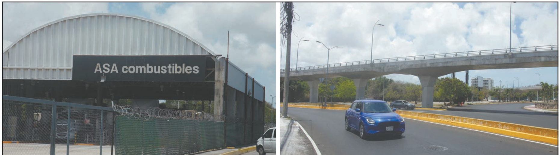
Además de proyectos viales, como la colocación de señalética, modernizarán el 35% de la planta de almacenamiento de Aeropuertos y Servicios Auxiliares, ubicada en el AIC.
