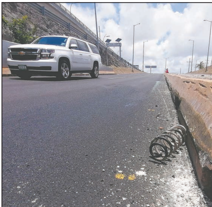
En la zona quedaron tirados resortes de suspensión dañados.
