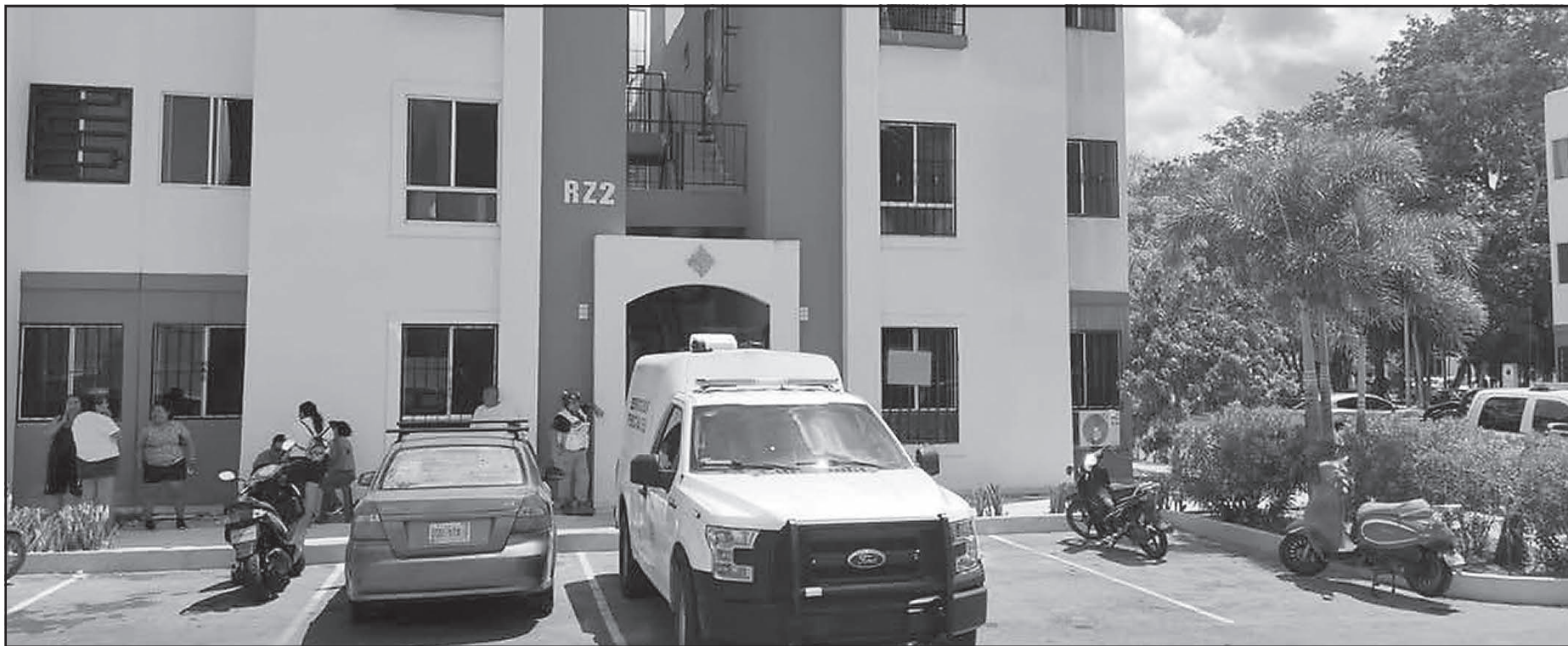
Autoridades ministeriales indagan la falta de equipo de protección adecuado en las alturas en el percance suscitado en el fraccionamiento ubicado cerca de la CTM. (G. Escalante)
