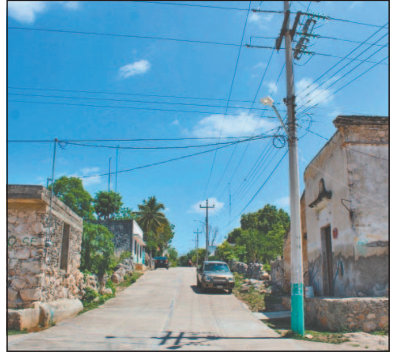
Vecinos señalan infraestructura obsoleta y postes deteriorados.
