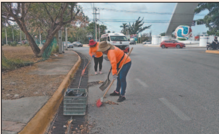
La Canirac considera un acierto la limpieza de alcantarillas. (A. Pech)
