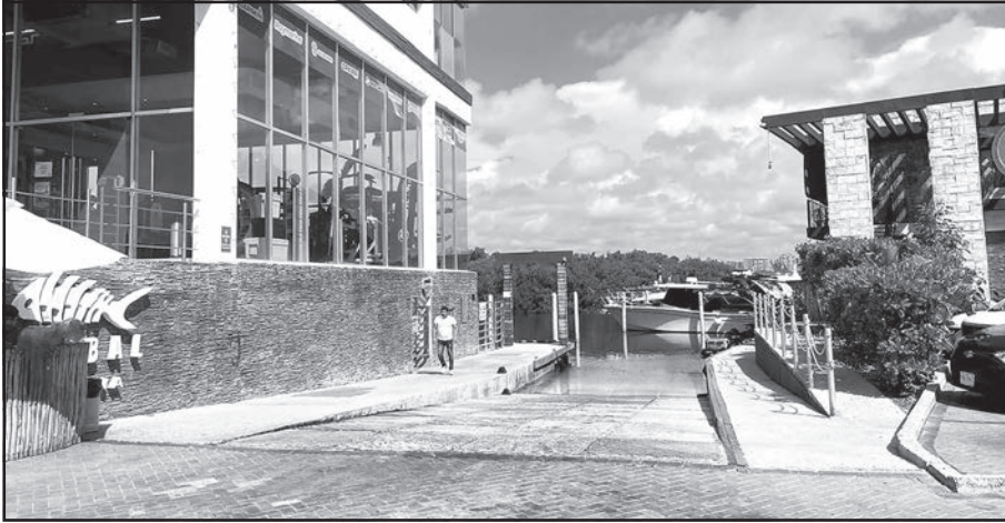
Contar con un espacio de maniobra ayuda a retirar las unidades sin mayor riesgo.
