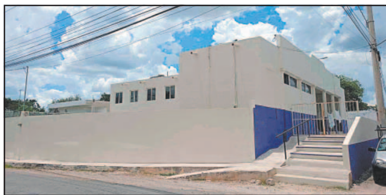
Ya se tiene un 80% de la obra lista; se espera terminar pronto. (E. C.)
