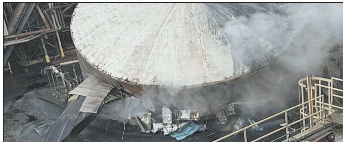
El depósito está liberando una mezcla química muy destructiva llamada "licor blanco". (Agencias)
