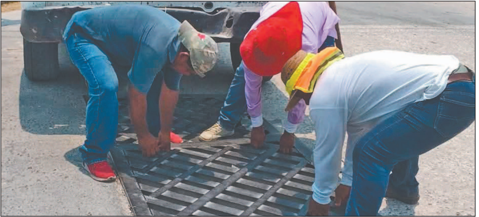
Diversos afectados demandaron trabajos de prevención antes de que la frecuencia de precipitaciones pluviales impida la realización de cualquier labor. (Pedro Díaz)
