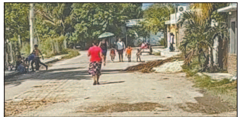
Requieren nivelación porque se estanca el agua pluvial. (Jorge M.)
