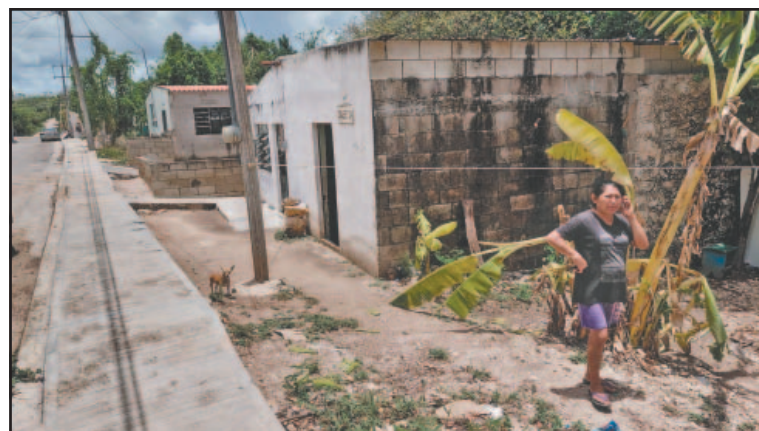
La falta del suministro en seis viviendas se debió a una mala instalación.
