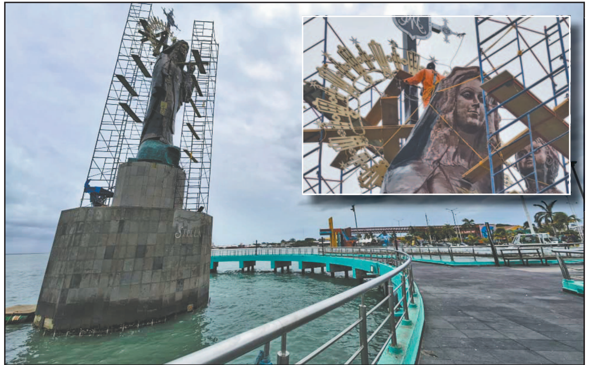
Personal experimentado realiza los trabajos de la estructura desde la base hasta la cima. (Perla Prado)
