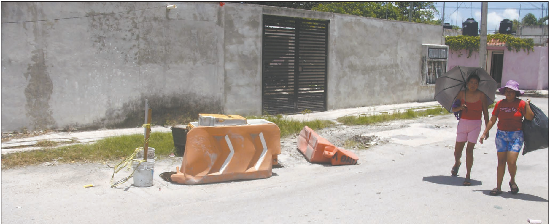
Pese a los reportes de manera frecuente, los inconformes señalaron que personal del Ayuntamiento solo colocó barreras móviles y señalamientos improvisados para advertir del riesgo.
