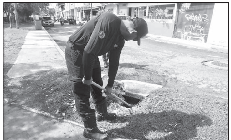
Fue desazolvada la red pluvial en colonias y Centro Histórico. (O. López)
