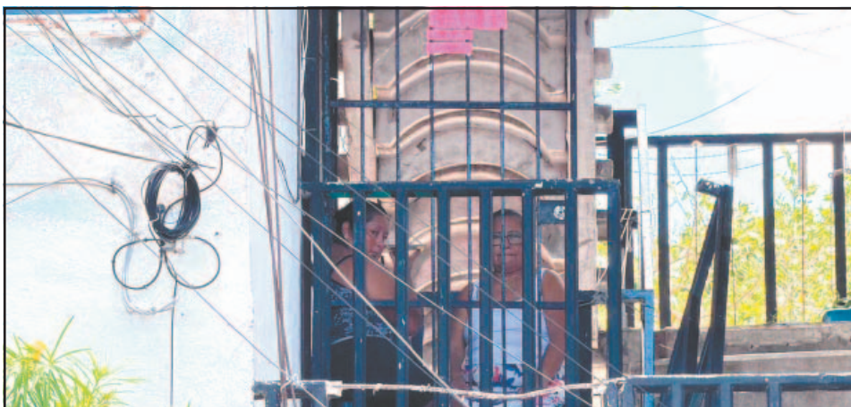
Desde hace años vecinos han denunciado el deterioro progresivo de los inmuebles.
