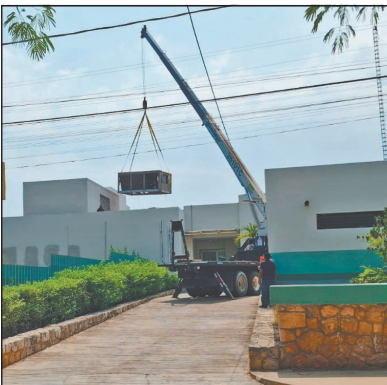
Con ayuda de una grúa se colocaron en el interior del nosocomio.
