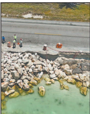
Actualmente la SICT repara un tramo de la carretera federal.
