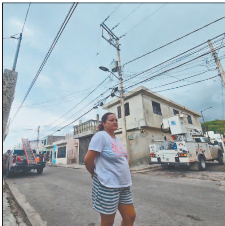
Los vecinos exigieron que les cambien el transformador. (A. Pech)
