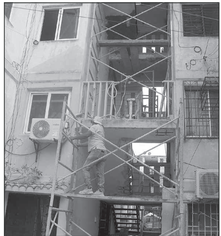
Los vecinos se organizaron para iniciar las reparaciones. (E. Romero)
