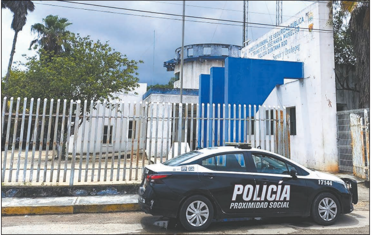
El inmueble está ubicado en la calle Gonzalo Guerrero. Antes, Seguridad Ciudadana usaba el Palacio como estacionamiento para sus patrullas. (L. Kauil)
