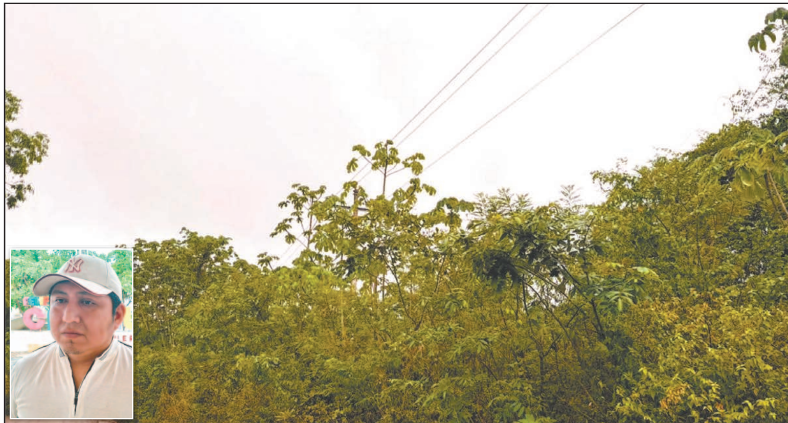
El subdelegado Saulo Uex dijo que las cuchillas cayeron debido a que ramas de los árboles chocaron con cables eléctricos. (Fotos J. Xiu)
