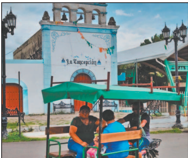
PREOCUPA a los creyentes, que pueda ocurrir un derrumbe similar al registrado hace dos años en la iglesia de San Luis Obispo .- (Erik Caamal)
