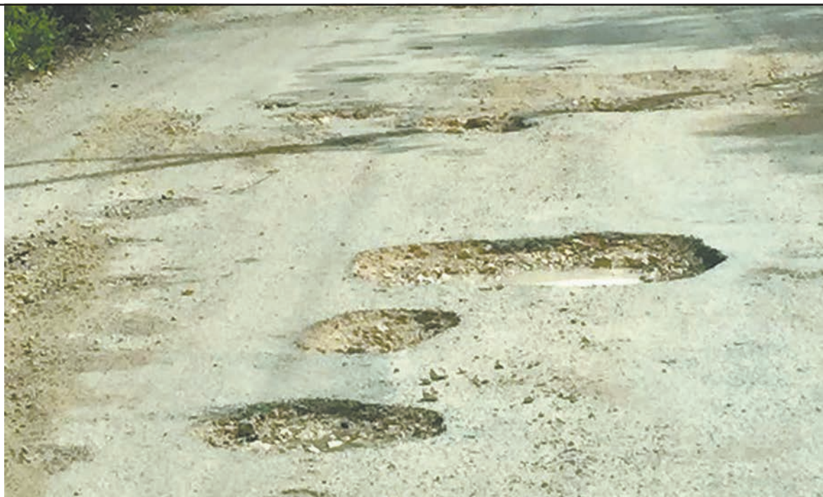
El camino fue construido con una capa de tres centímetros, cuando la norma internacional establece entre seis y 12; desde entonces, los hoyos solo son remendados . (Fotos O. López)
