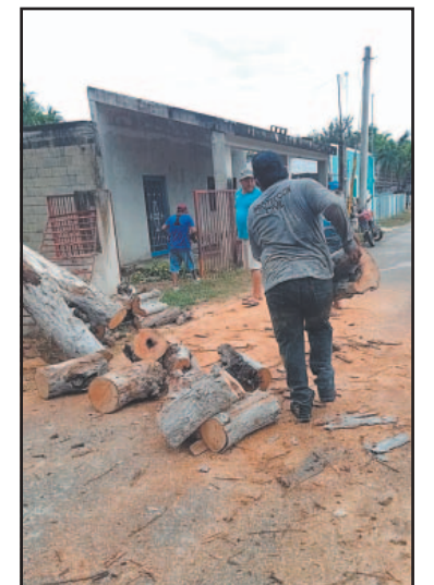
Protección Civil retiró ramas que tiraron el viento y las lluvias.
