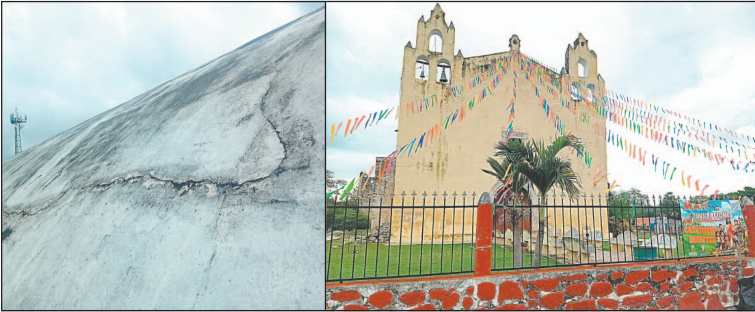
Las intensas lluvias que han afectado el estado en los últimos días ponen en evidencia el deterioro que presenta el inmueble. (S. Pool)
