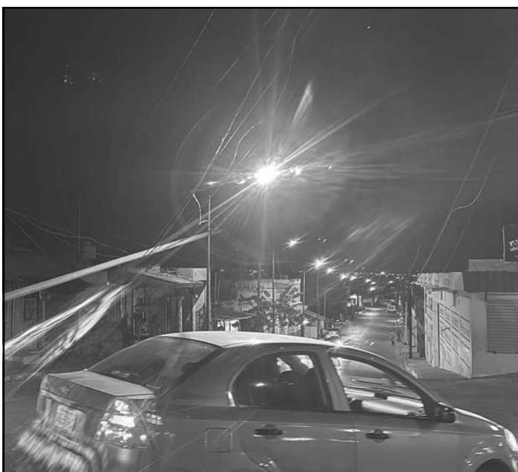
La estructura quedó colgada a media calle, sostenida solo por cables.
