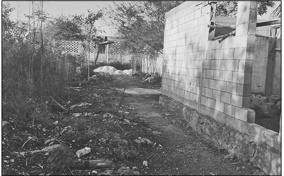
Para los vecinos el inmueble es irregular porque está sobre un terreno que pertenece al ejido. (Erik Caamal)
