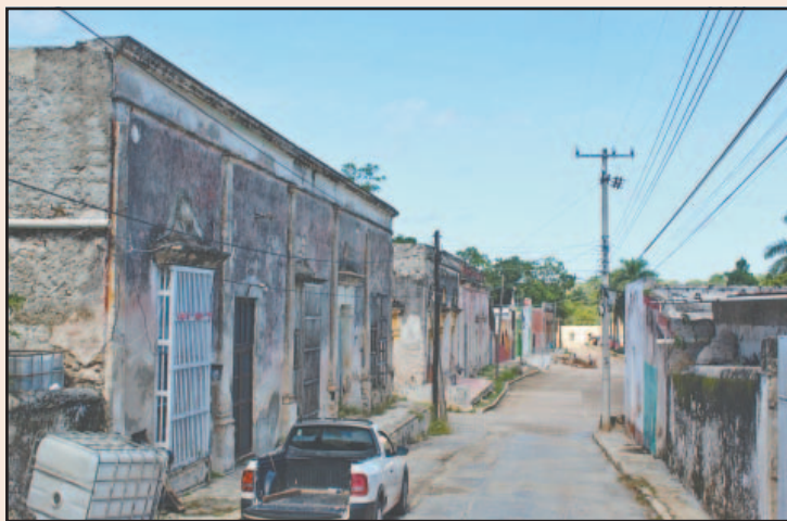
El servicio eléctrico ha presentado numerosas fallas. (M. Koh)
