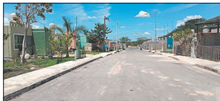
La vialidad tiene desperfectos que afectan sus vidas diarias. (E. S.)
