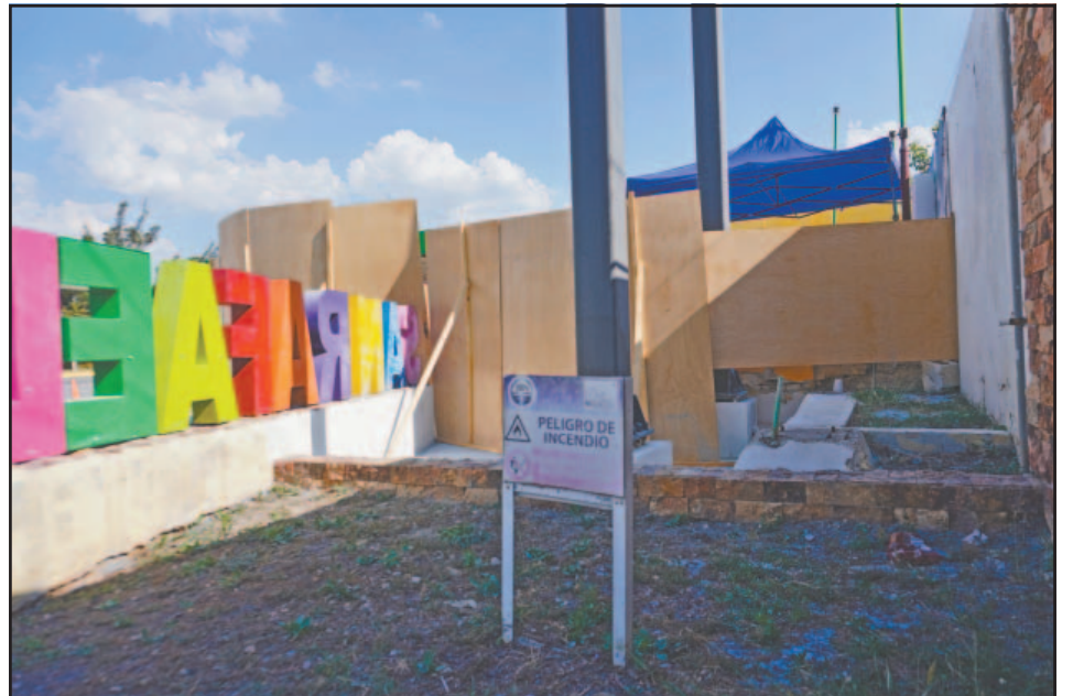
La zona afectada fue acordonada y recibió una inspección inmediata. (Lucio Blanco)
