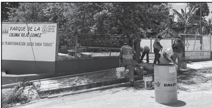
La obra está enfocada en sustituir el piso de los andadores. (Lusio Kauil)
