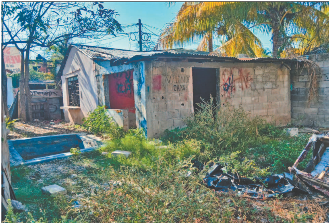
El lugar es peligroso para los vecinos y un "foco" de contaminación por el mal olor. (Joaquín Guevara)
