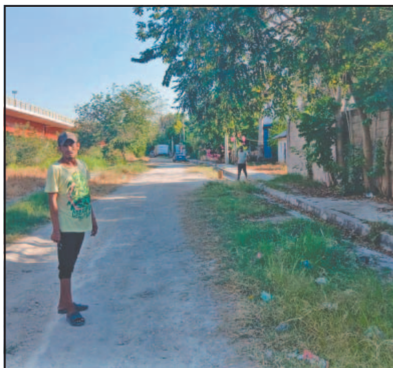
Hay maleza por todas partes y huecos que han generado accidentes viales y peatonales. (J. Guevara)
