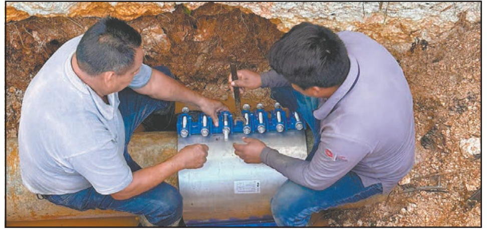
Sustituyeron una abrazadera desgastada que afectaba el suministro. (Fotos J. Xiu)
