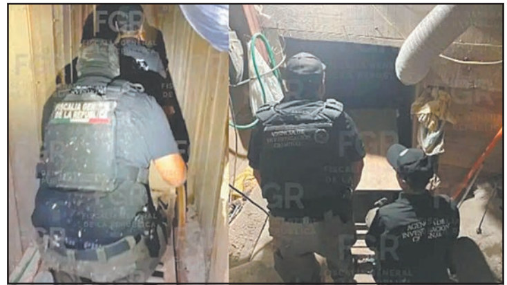
El conducto tiene una longitud de 265 m y una profundidad de 6.30 m.
