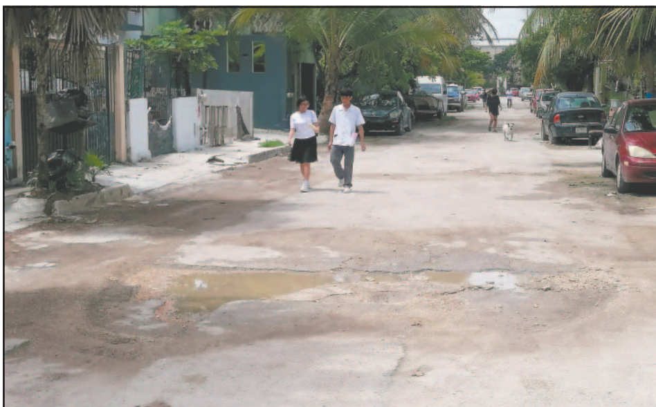
La principal demanda en fraccionamientos es la repavimentación integral de zonas anegadas.
