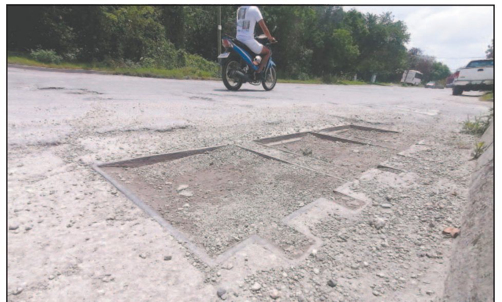
Ciudadanos aseguraron que las alcantarillas están saturadas por el lodo endurecido.
