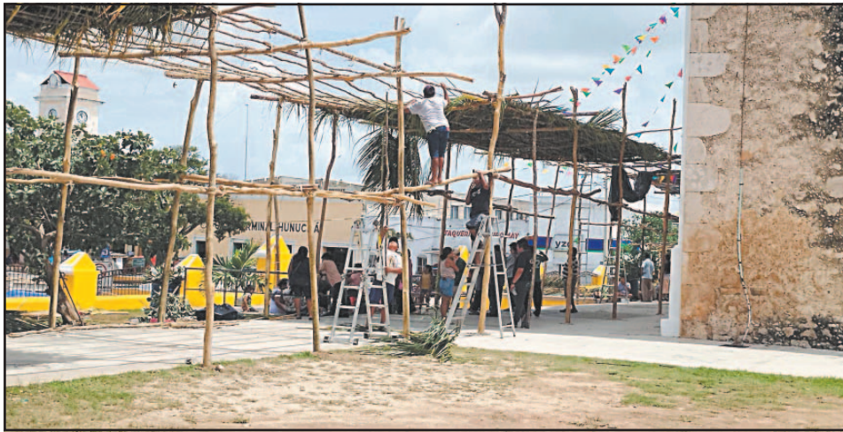
Debajo de la estructura serán colocadas ofrendas provenientes del campo. (POR ESTO!)
