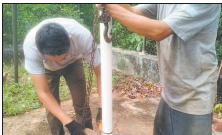
Se realizaron trabajos de mantenimiento del sistema. (POR ESTO!)
