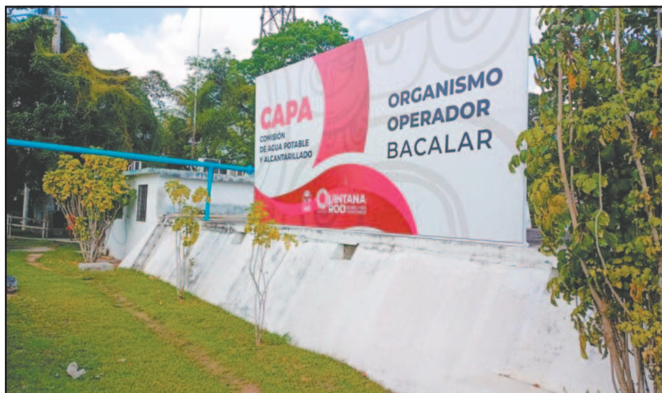
La paraestatal señaló que tratan de buscar una solución a la falla, pero no han podido.
