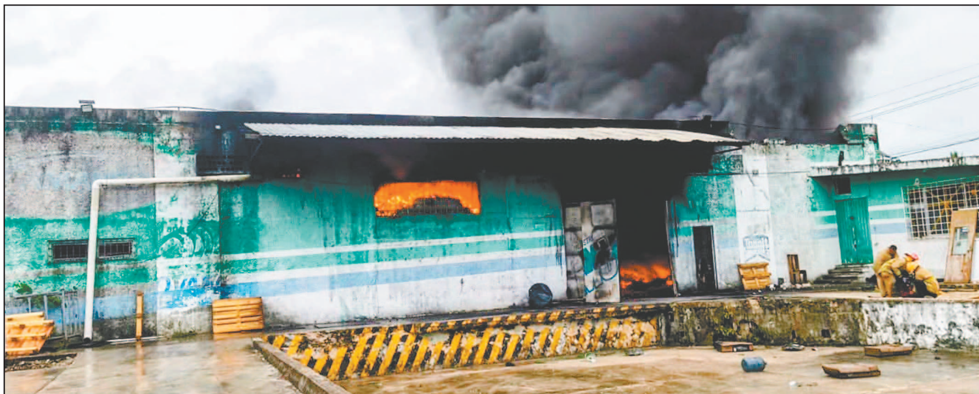
Conductores que circulaban cerca del Parque Industrial alertaron a las autoridades debido a que una humareda invadía la zona, al arecer por una ignición. (Fotos F. Olvera)
